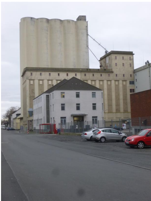
Abb. 3: Verwaltung, Ellsilo (Putzbau) und Hochsilo bzw. Beton-Röhrensilos an der Siegburger Straße, 2016. Foto: Susanne Schöb.
