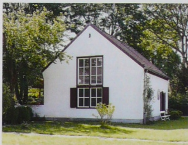
94. Düsseldorf-Golzheim, Franz-Jürgens-Straße. Blick nach Norden.
