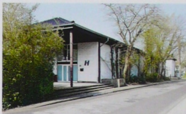
93. Düsseldorf-Golzheim, Franz-Jürgens-Straße. Blick von Osten.
