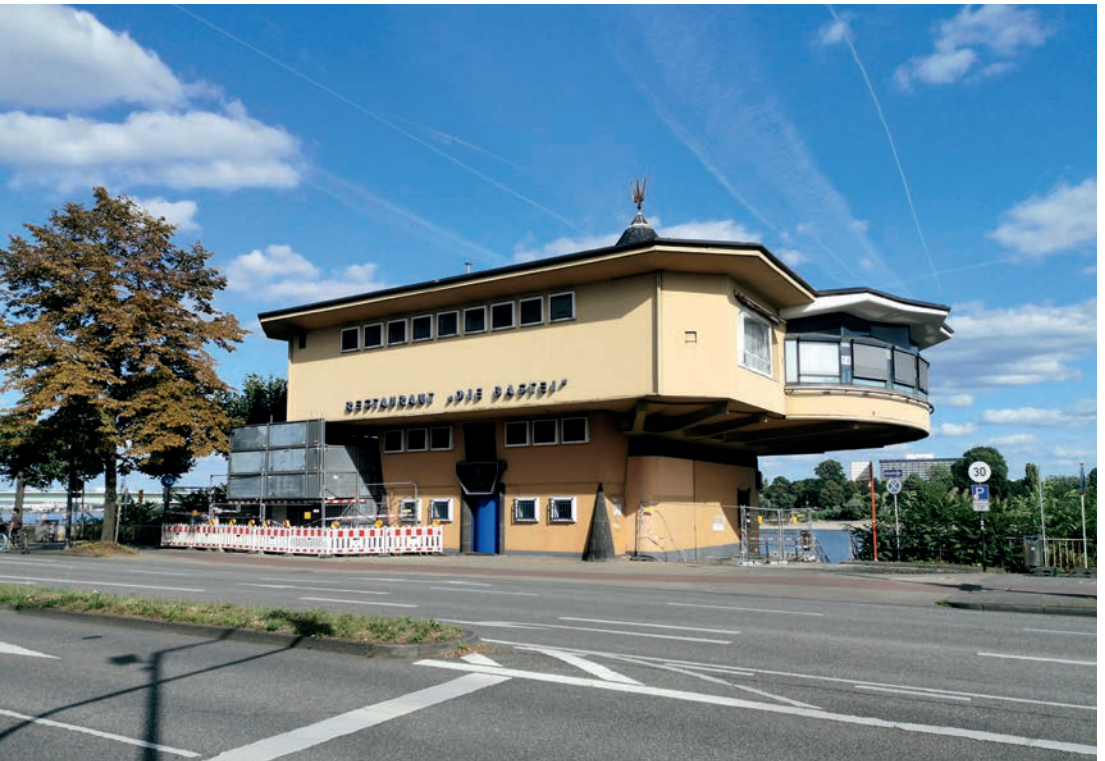
Die Bastei von Südwesten (21.8.2024) © Ulrich Krings
